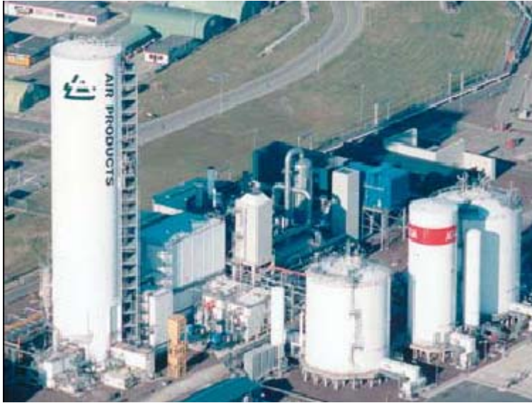
Şekil 3.9b 3000 ton/gün oksijen tesisi.
