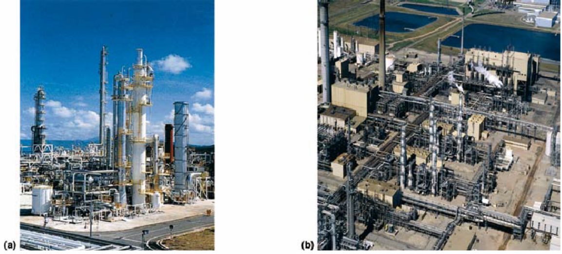
Şekil T4 (a) Malezya'daki bir santralde yakım sonrası karbondioksit tutumu.
